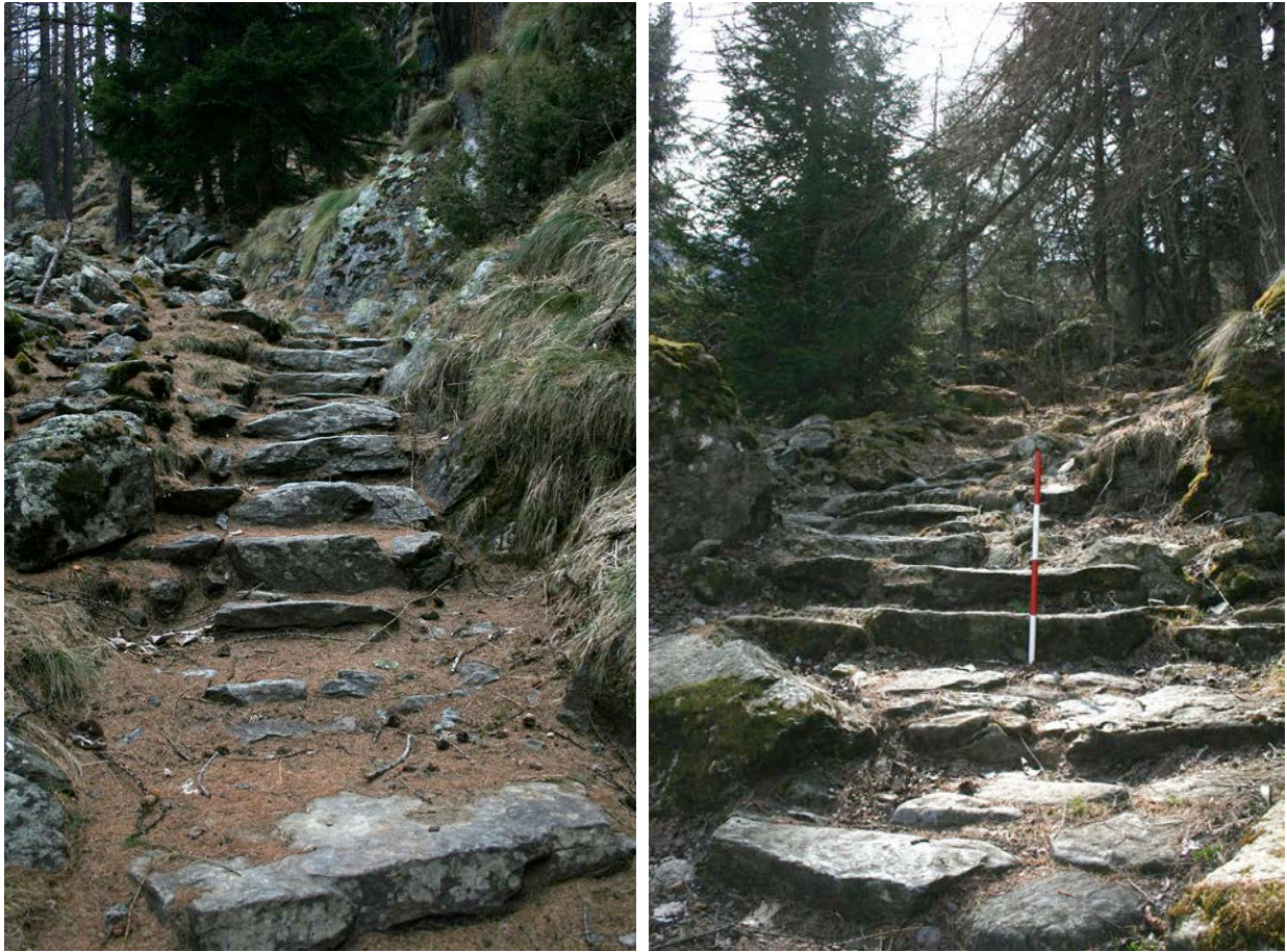
Figura 13 Due esempi di pavimentazione a gradoni (altezza di 20 cm.), che consentono un'agevole camminata e che saranno tolti per creare un fondo pianeggiante percorribile dai mezzi a motore
