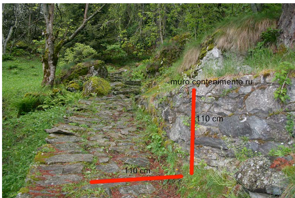
Figura 16 Il muro di contenimento del ru, qui sulla destra, affianca la mulattiera in molti tratti. Potrà essere “spostato” e sostituito da qualsiasi manufatto (es tubi in plastica) secono le prescrizioni del Comune, che richiede unicamente che “sia mantenuta la continuità del ru”
