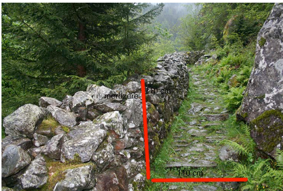
Figura 18 La sezione della mulattiera esistente è di 110 cm, appena più basso è il muro che la costeggia ("mourdzie")
