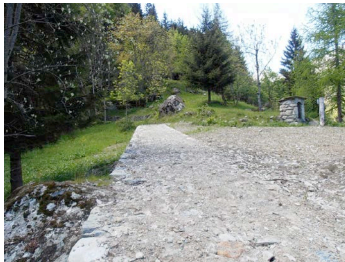
Figura 12 Ultimo tratto della seconda variante (alla larghezza della pista(2,50 m), si aggiunge il terreno confinante che è stati liberato dai massi)
