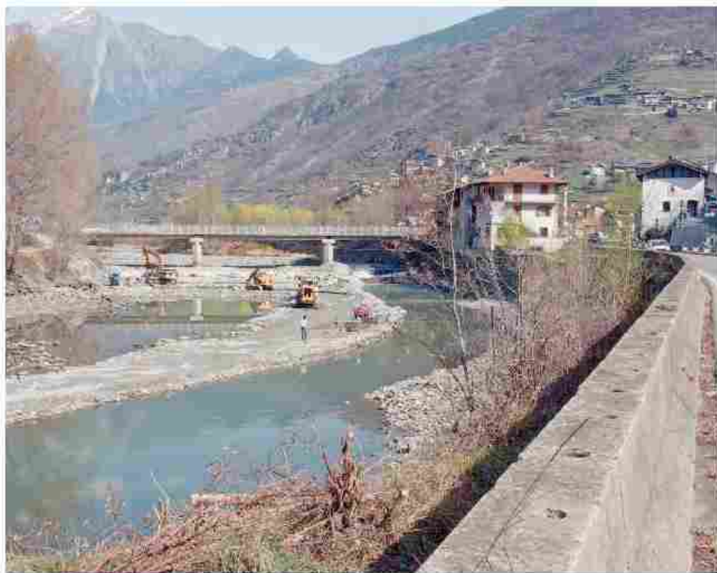
Il tratto della Dora Baltea individuato per la realizzazione della centralina
